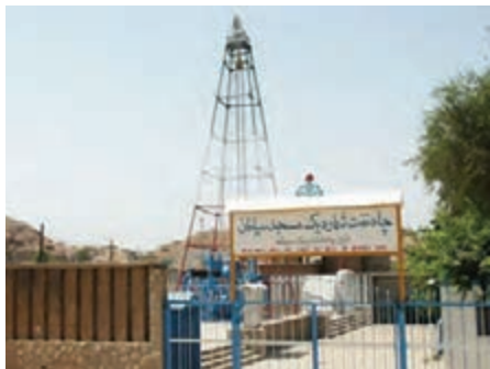
شکل ۷-۱۲- چاه شماره یک مسجد سلیمان
