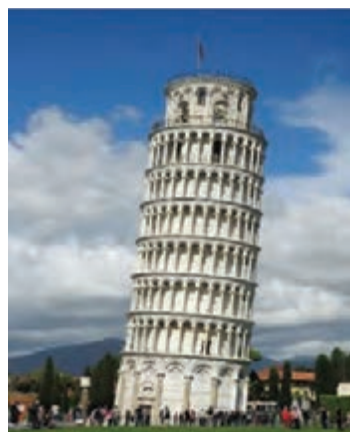
شکل ۱-۶ نشست نامتقارن پی در برج پیزا
