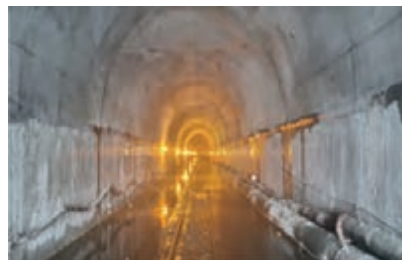
الف) پوشش های بتنی در مغارها
