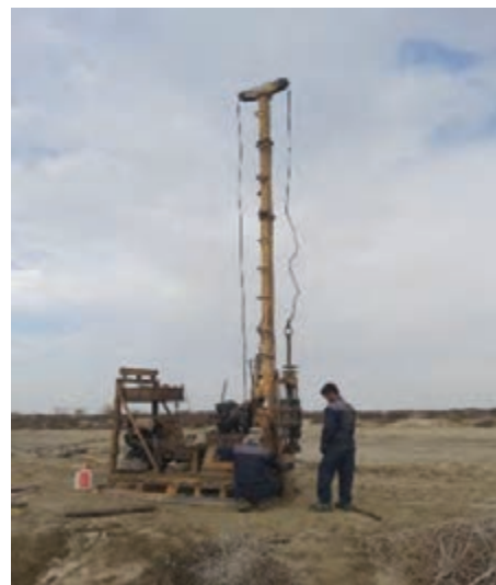
شکل ۶-۳ حفاری گمانه اکتشافی توسط دستگاه حفاری
