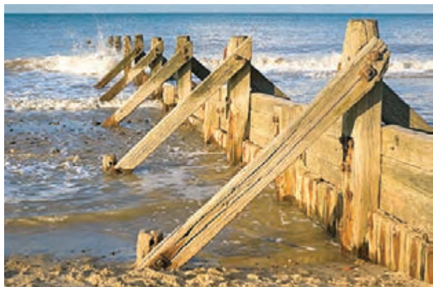
نصب حفاظ عمودی
